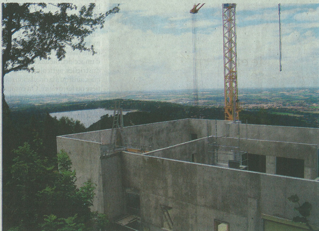
Actuellement, l'Institution des eaux de la Montagne Noire poursuit ses travaux à l'usine de Picotalen pour augmenter sa capacité de production d'eau potable. Photo IEMN.
