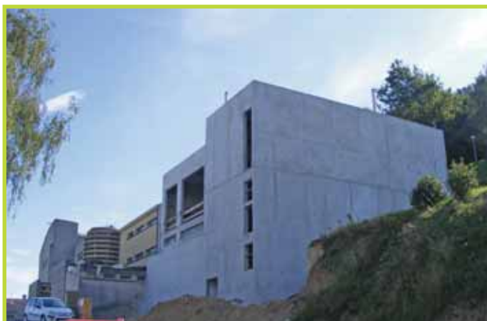
Travaux de génie civil - vue avant
