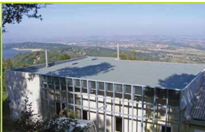
Pose de la toiture - vue arrière
