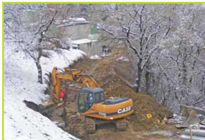
Pose de réseaux vers Pic Boue
