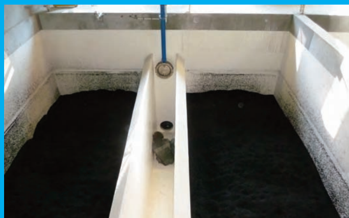
Filtres bicouche, sable et charbon actif en grain
