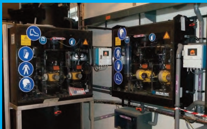
Pompes doseuses réactifs
