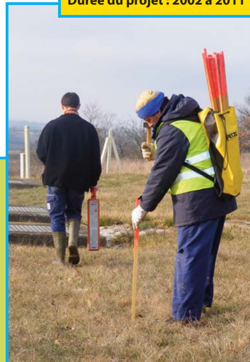
Repérage et piquetage des conduites d'eau
