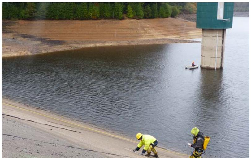
L'examen, réalisé en majorité par le bureau d'expertise ISL, s'est tenu du 12 au 16 octobre. La société JIFMAR est intervenue pour faire un scan 2 D du parement amont, le passage avec robot sur des zones à contrôler, le scan 3 D du pied de la tour de prise et du « bouchon » de la galerie de dérivation provisoire. A la suite des inspections, seule la présence d'un début d'envasement en pied de barrage a été constatée.
