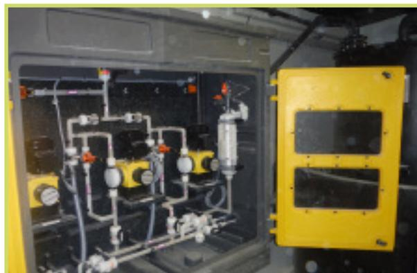
*Pompes d'injection d'acide pour la régulation du pH avant la flottation.*
