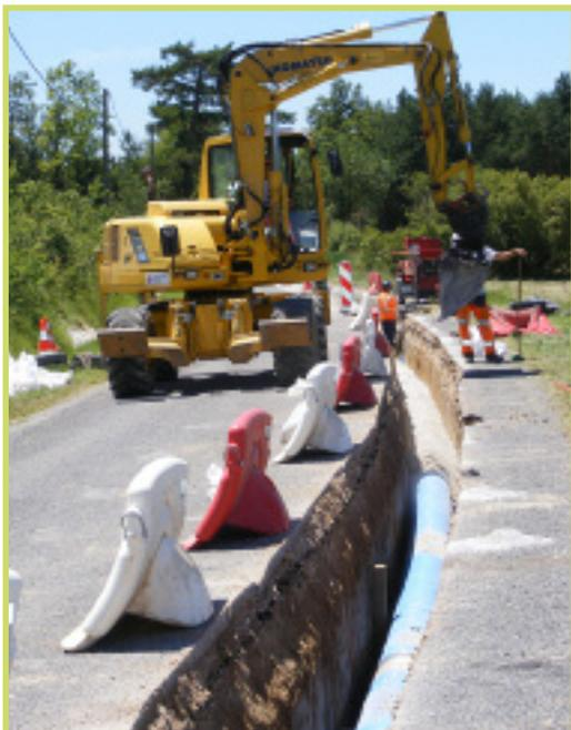
*Pose de la nouvelle canalisation en Ø 400 sous la RD79D.*
