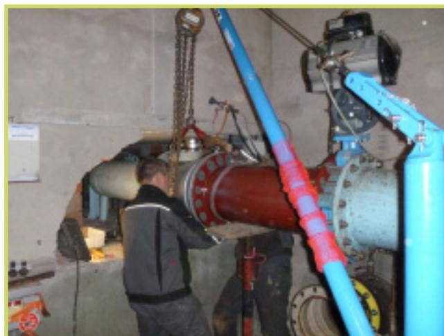
Pic 2 : Pose d'un débitmètre électromagnétique.
