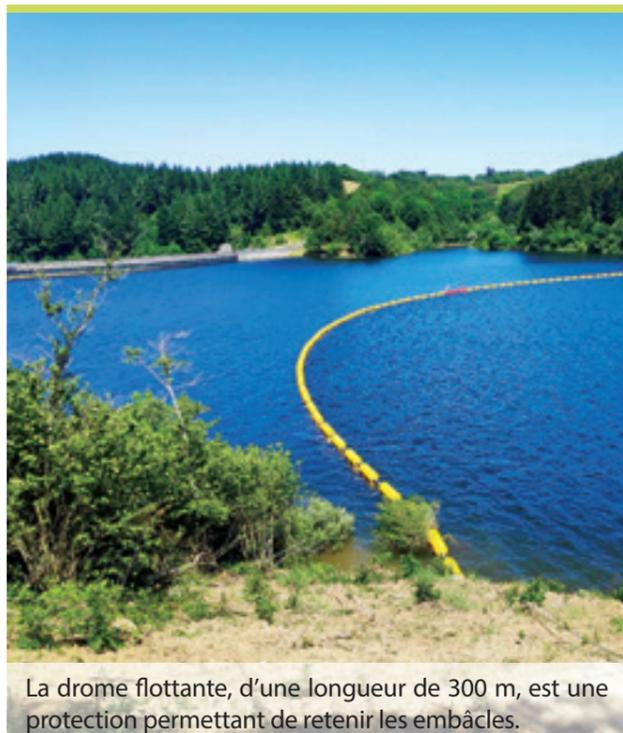
La drome flottante, d'une longueur de 300 m, est une protection permettant de retenir les embâcles.
