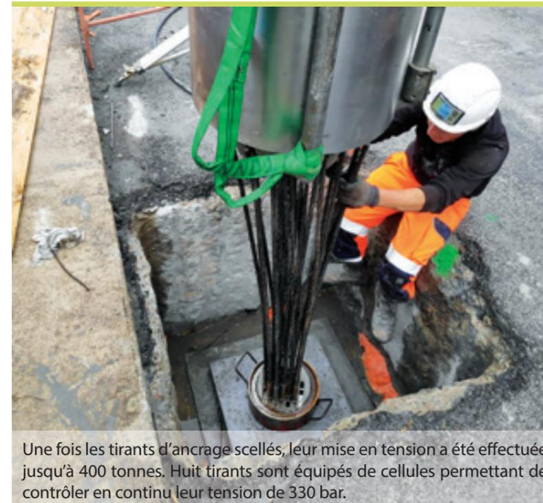
Une fois les tirants d'ancrage scellés, leur mise en tension a été effectuée jusqu'à 400 tonnes. Huit tirants sont équipés de cellules permettant de contrôler en continu leur tension de 330 bar.
