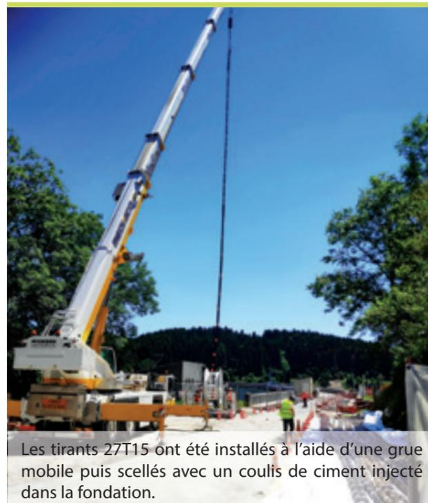
Les tirants 27T15 ont été installés à l'aide d'une grue mobile puis scellés avec un coulis de ciment injecté dans la fondation.
