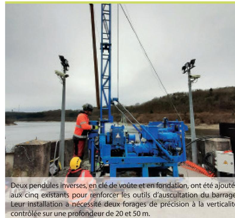
Deux pendules inverses, en clé de voûte et en fondation, ont été ajoutés aux cinq existants pour renforcer les outils d'auscultation du barrage. Leur installation a nécessité deux forages de précision à la verticalité contrôlée sur une profondeur de 20 et 50 m.
