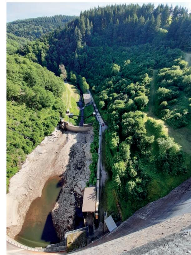
du barrage. Pour ce faire, l'eau brute a directement été prise dans le barrage puis acheminée vers les usines de traitement via le réducteur de pression. A cette occasion, l'entreprise Spie Capag a réalisé des travaux de terrassement pour dégager l'accès à la galerie et aplanir le fond du contre-barrage.
