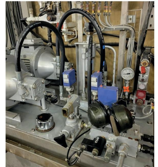
remplacé certains flexibles (tuyaux d'alimentation des vérins) afin d'assurer leur bon fonctionnement. Le déplacement des vérins a été réalisé par bateau sur la retenue, garantissant ainsi une intervention efficace et sécurisée. Le coût total de cette opération s'élève à 23 824 € HT.
