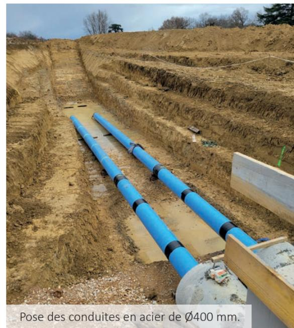
Pose des conduites en acier de  $\varnothing 400$  mm.
